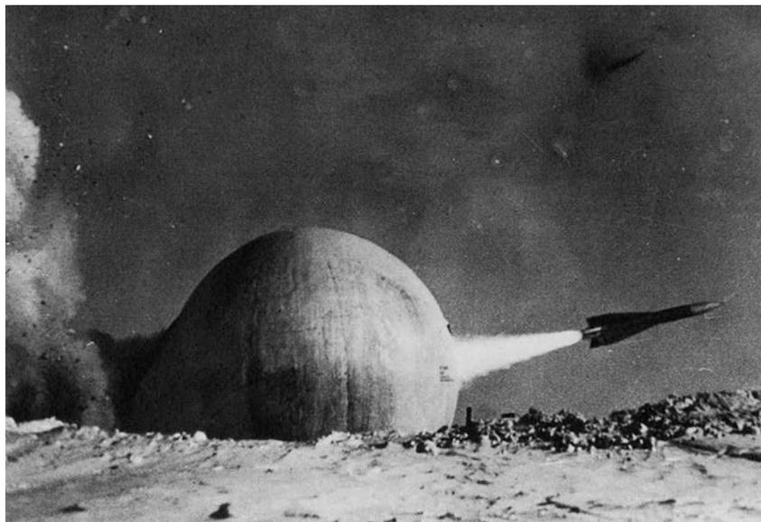
por una membrana estabilizada estructuralmente mediante pequeñas diferencias de presión creadas por la aplicación de la energía ambiental. Si bien es cierto, tal y como dijo Bird, existían registros de patentes sobre ideas arquitectónicas de estructuras soportadas por aire desde 1917, pero la primera aplicación práctica de la idea se produjo con la Radome<sup>7</sup>, y puede ser considerada la primera construcción neumática en la historia de la arquitectura.
