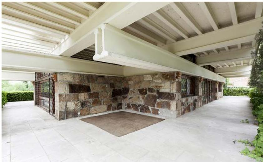
adquirido diferentes colores debido a la meteorización y oxidación de la misma, conforman la estructura de las plantas baja y primera, dispuestos los cuatro muros exteriores en L y rectilíneos los muros del interior. Esta tipología hace que la planta contraste en sencillez con los alzados y vista al natural de la vivienda más complicados dado el entramado de vigas (Fig. 15).
