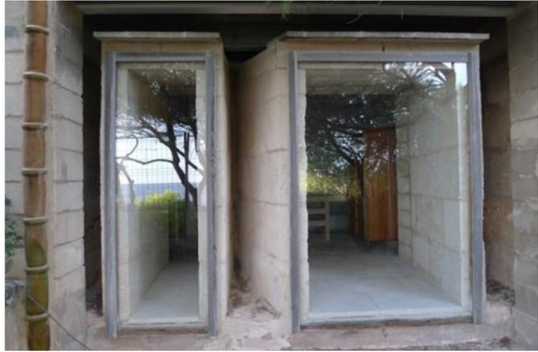
Fig. 02. Can Lis, desde fuera se observan los 'delgados' muros que delimitan y sujetan los huecos abocinados.
