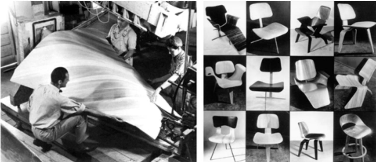
Fig. 02. Izquierda: lámina de madera contrachapada en proceso de moldeado para la construcción de la cola de un avión (taller de los Eames, Los Ángeles, 1943). Derecha: Charles y Ray Eames, prototipos de sillas de madera contrachapada (fotografías de Charles Eames, c. 1950).
