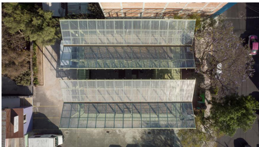
Fig. 8 y 9. Pílares, Mexico City. Camilo Restrepo Ochoa AGENdA with: TO arquitectos and UDEB arquitectos. Photos: Jaime Navarro
